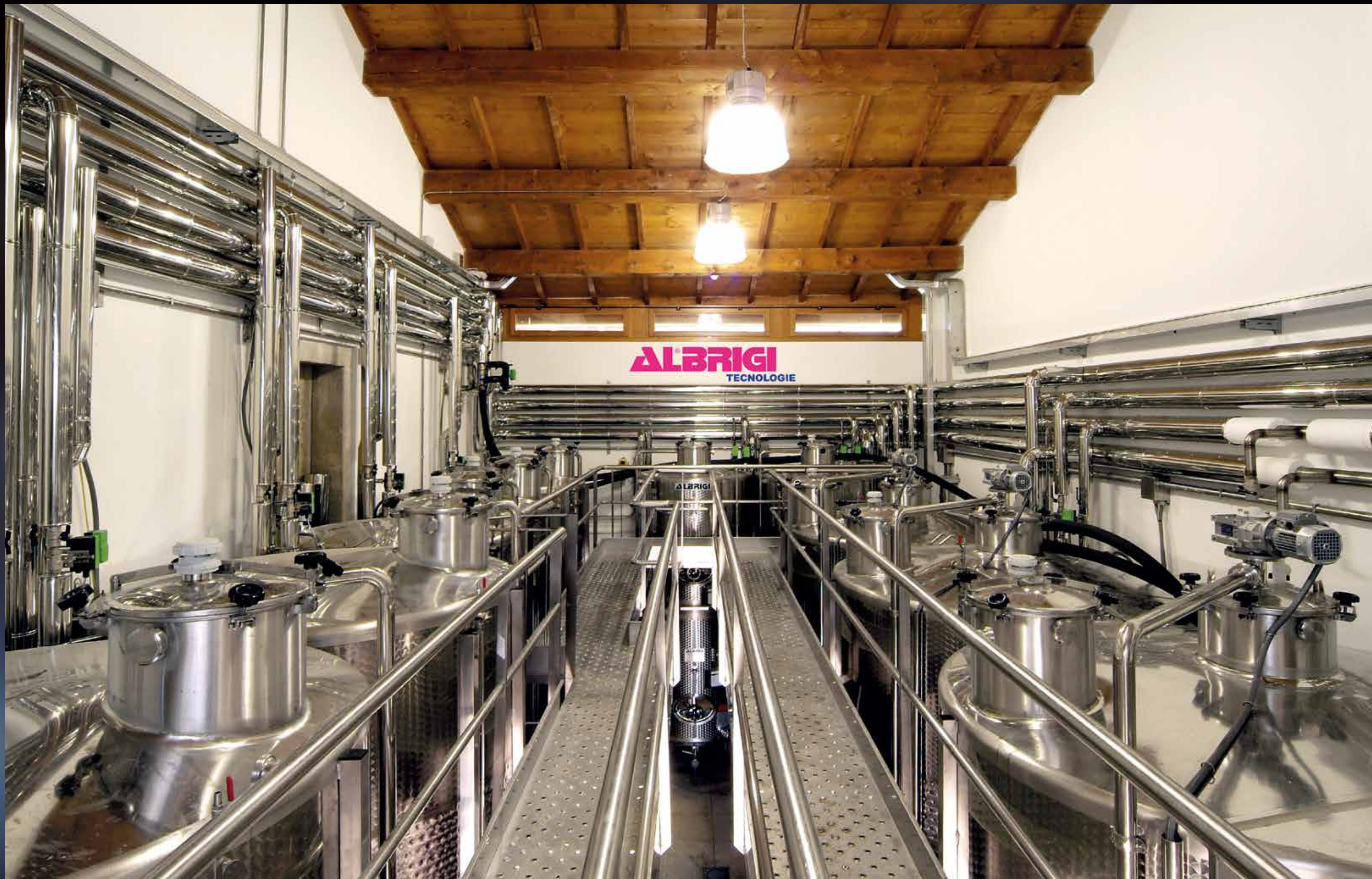
Impianto di condizionamento per vinificatori
