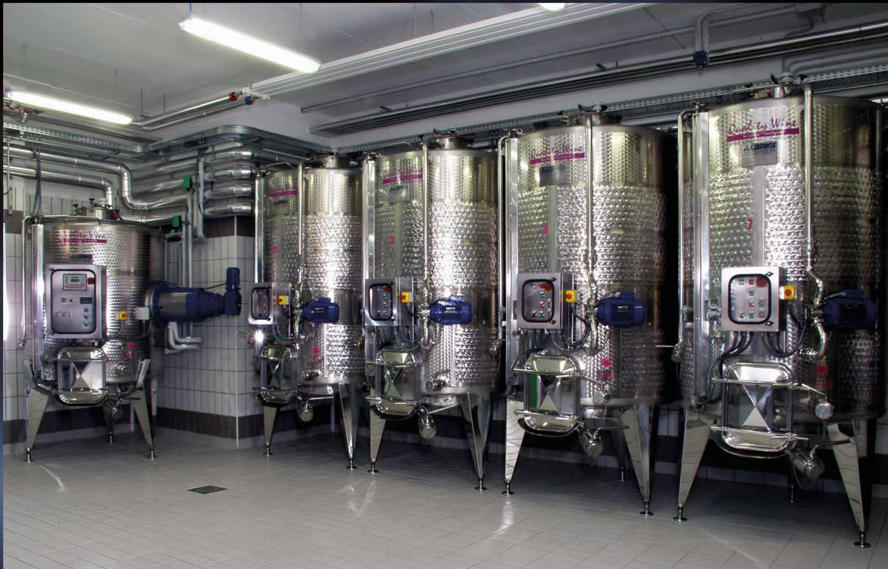
Volvotank da hl 20 e fermentatori Specialtank da 25 hl, termocondizionati con Termostar e con pompa di rimontaggio 25 hl
