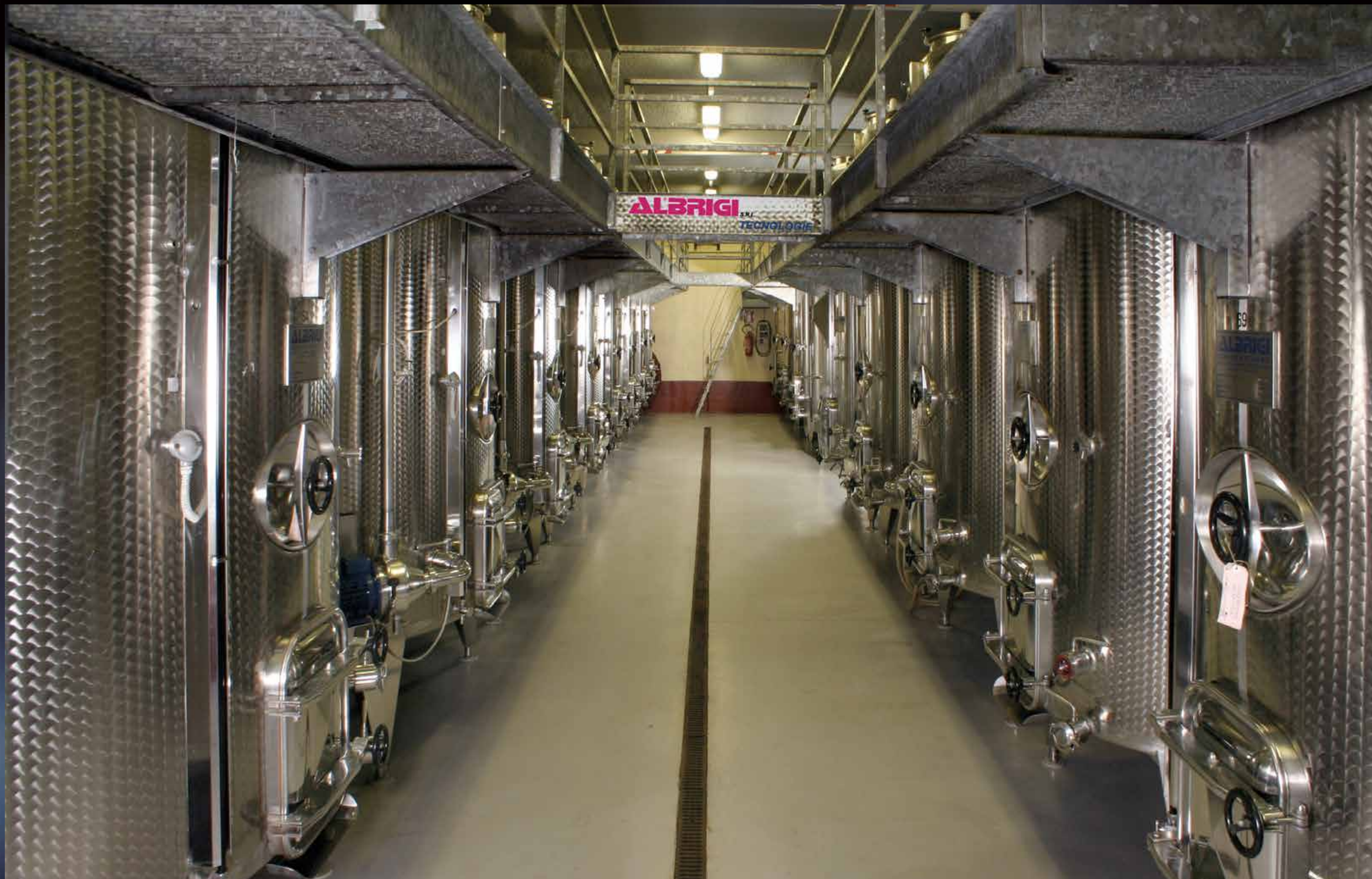
Specialtank da hl 100 e Criotank da hl 100
