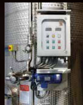
Quadro elettrico di gestione della pompa di rimontaggio e delle fasi di follatura
