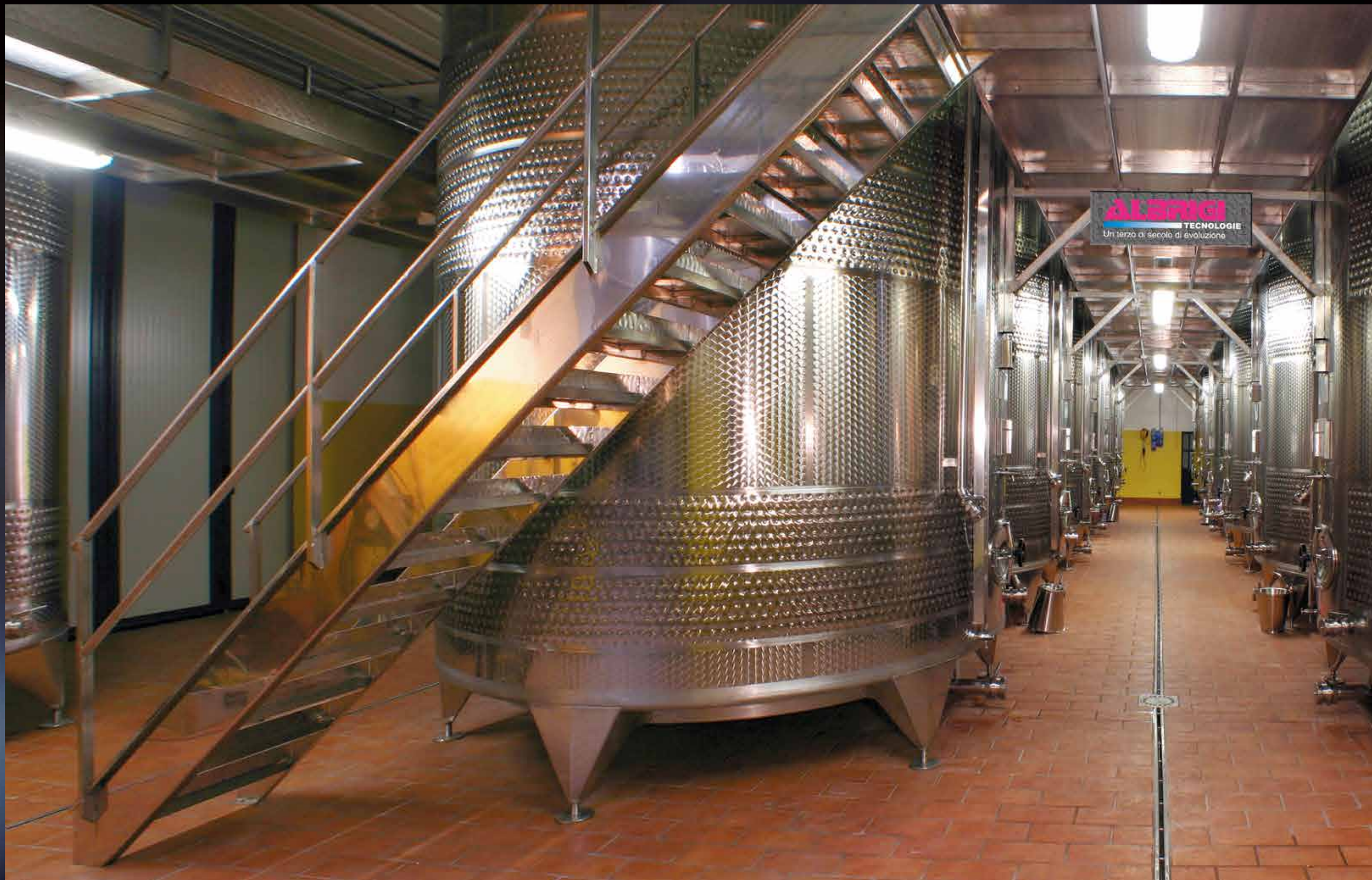
Cantina di fermentazione con Termotank da hl 300 termocondizionato con Termostar Double e con impianto di lavaggio fisso Cleanfix
