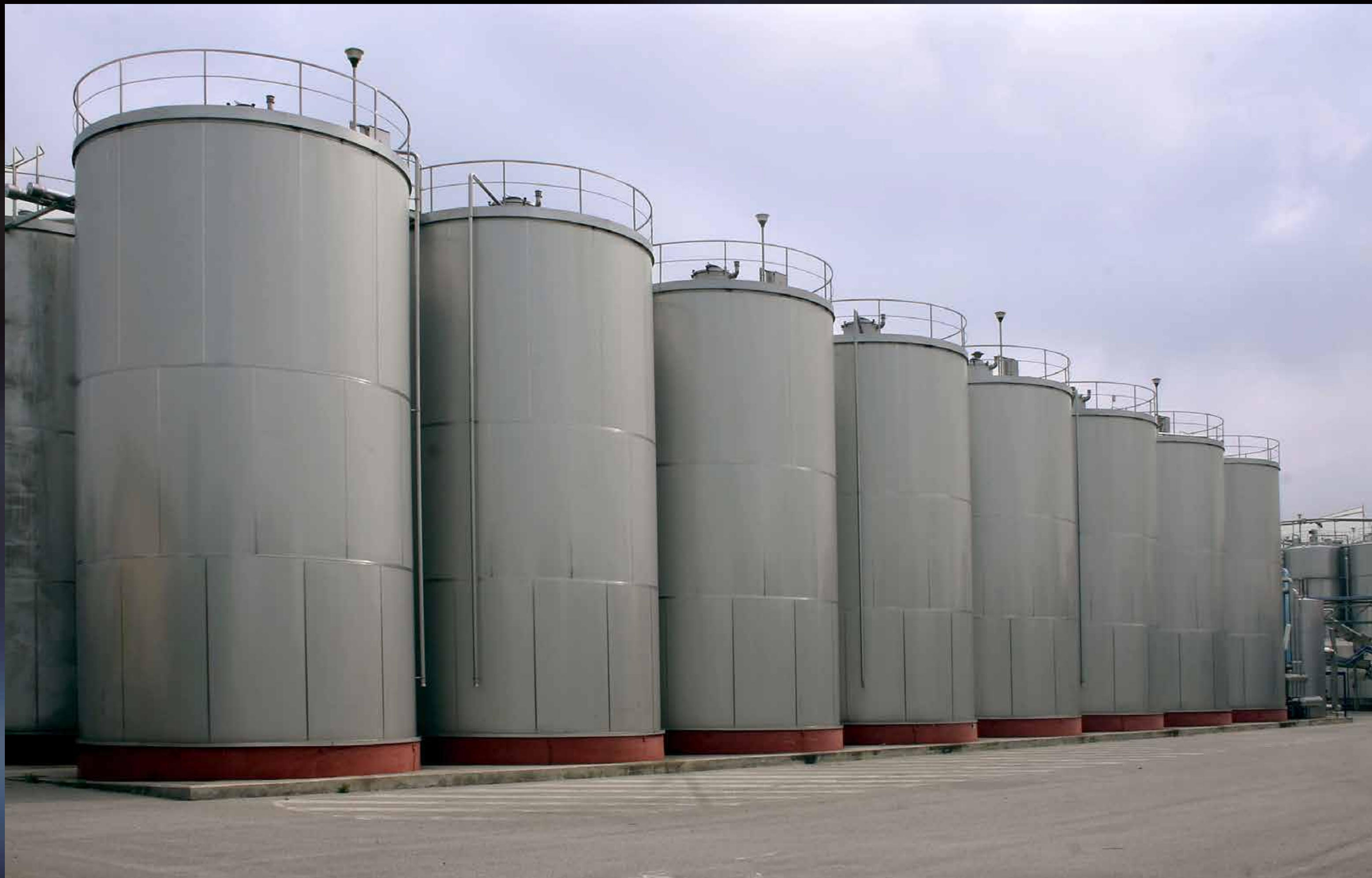
Megatank da hl 2500 in acciaio inox Aisi 304 L - cielo in acciaio inox Aisi 316L
