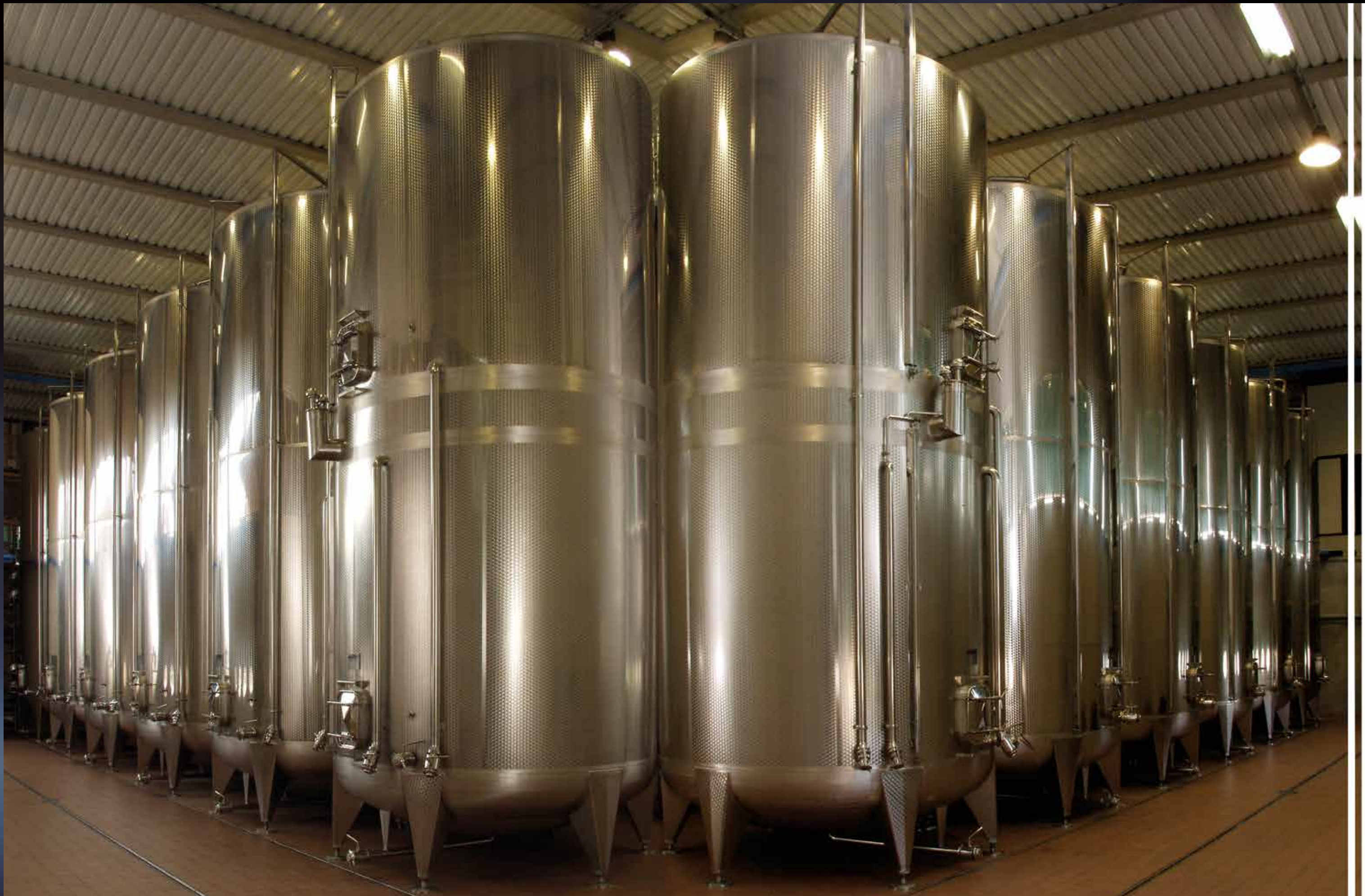
Bigtank da 750 hl e Politank da 360 + 360 hl con impianto di lavaggio Cleanfix, tutti con fondo bombato
