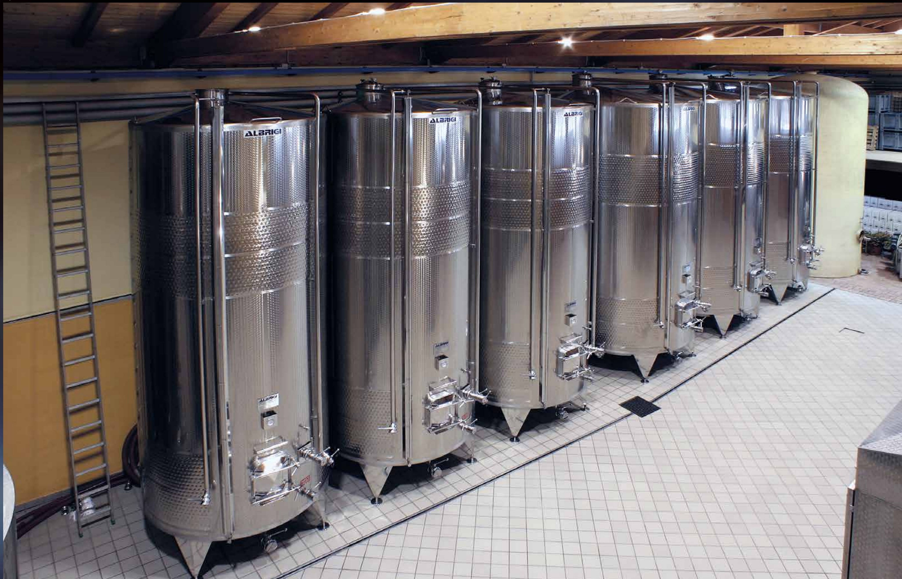
Vinotank da 150 hl termocondizionati con Termostar Double e impianto di lavaggio Cleanfix
