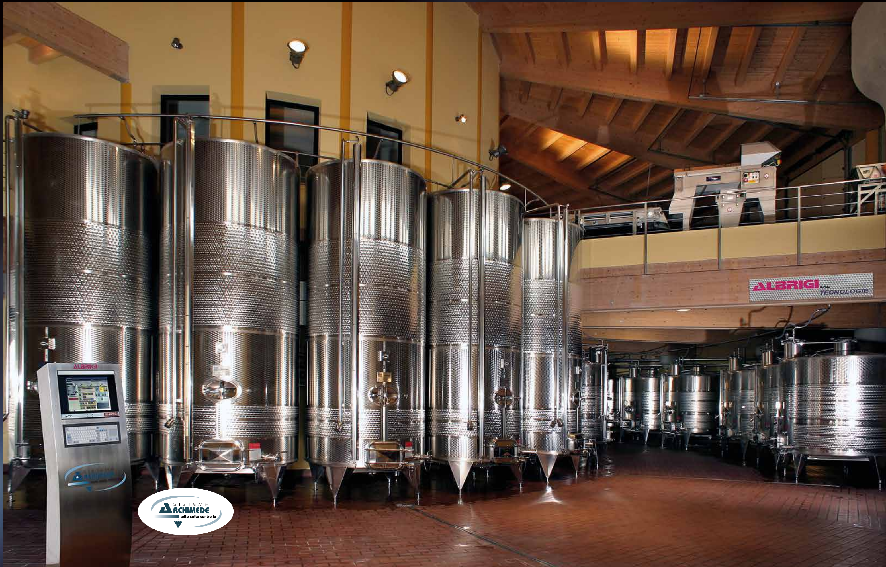
Specialtank termocondizionato con Termostar Double, impianto di lavaggio Cleanfix, impianto Innergas; Tutto l'impianto è controllato e gestito da Archimede
