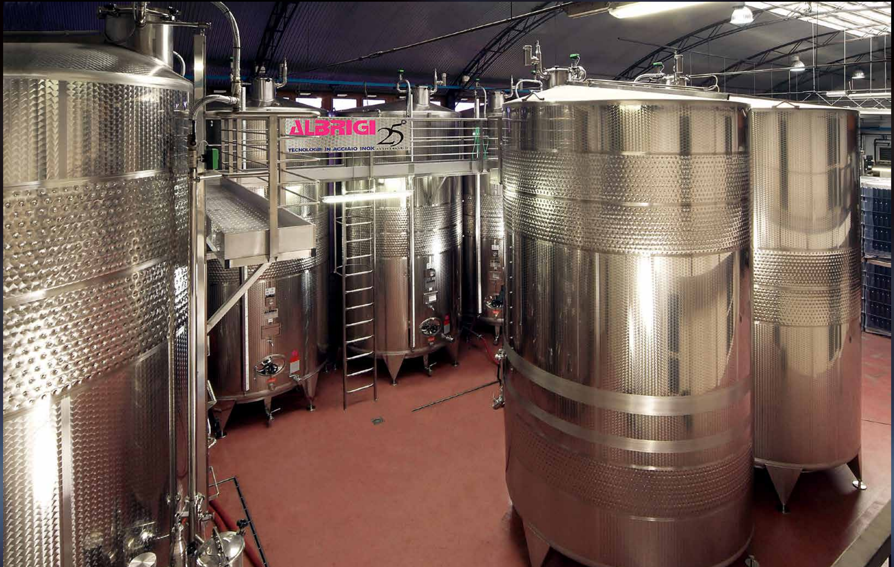
Termotank da 300 hl, Politank Termo da 150 + 150 hl e da 200 + 100 hl, tutti con innergas, impianto di lavaggio Cleanfix e passerelle di servizio
