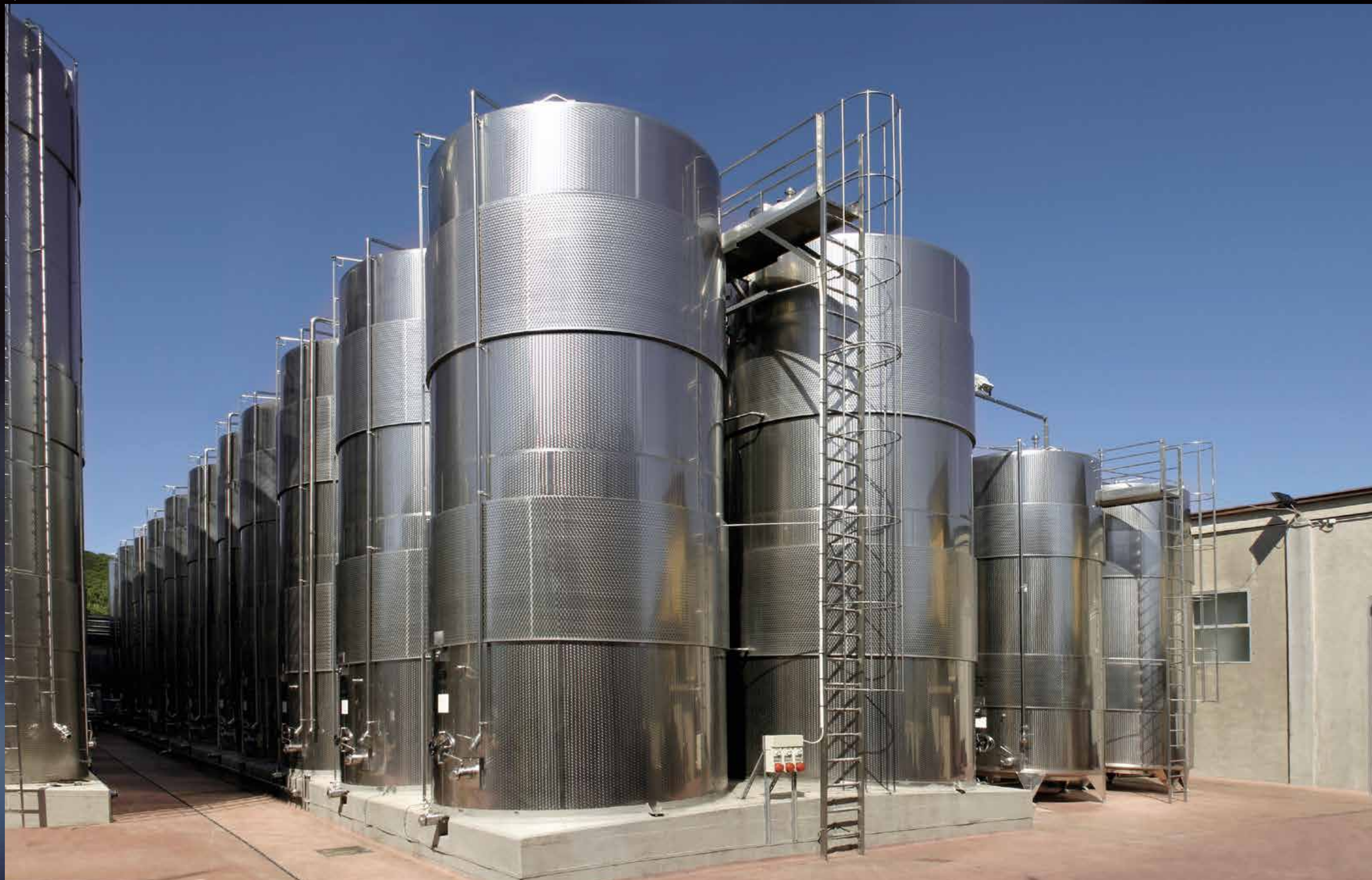
Megatank da hl 600 e Termotank da hl 300 termocondizionati con Termostar Double, isolati con Isoplus e impianto di lavaggio Cleanfix
