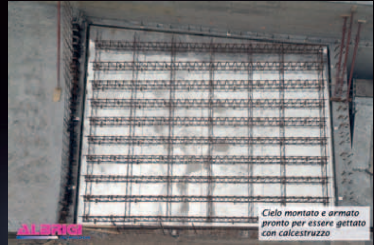
Teto montado e armado pronto para ser concretado
