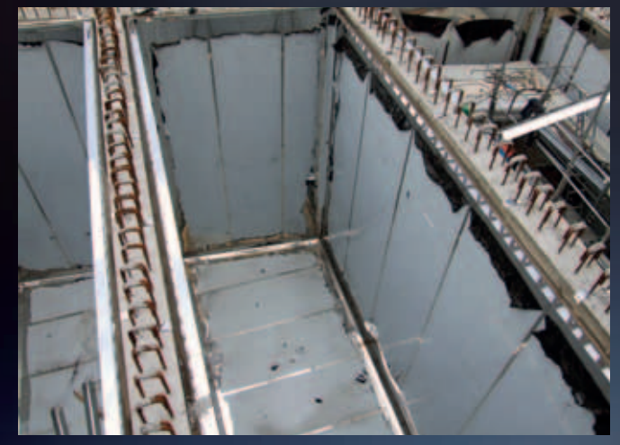
Teto montado e armado pronto para ser concretado
