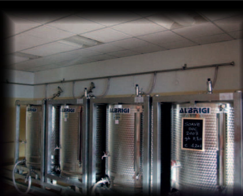
Instalação de armazenagem para venda de vinho a granel com instalação de inertização com azoto
