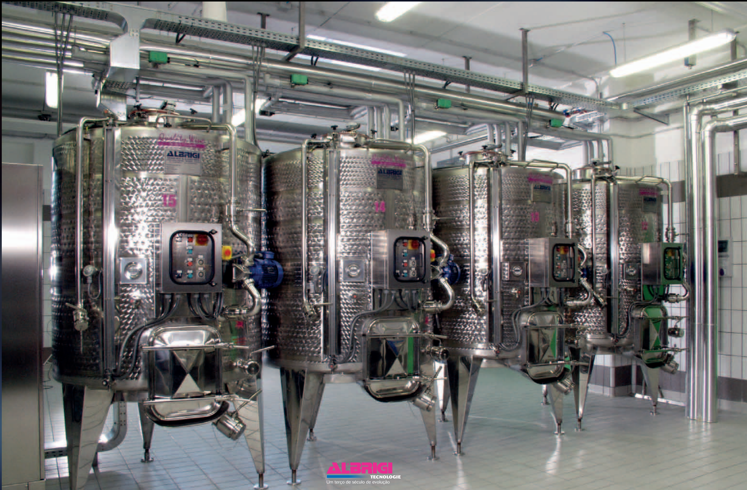
Vinificadores Specialtank termocondicionados com Termostar de 25 hl e 20 hl com délestage e bomba de remontagem
