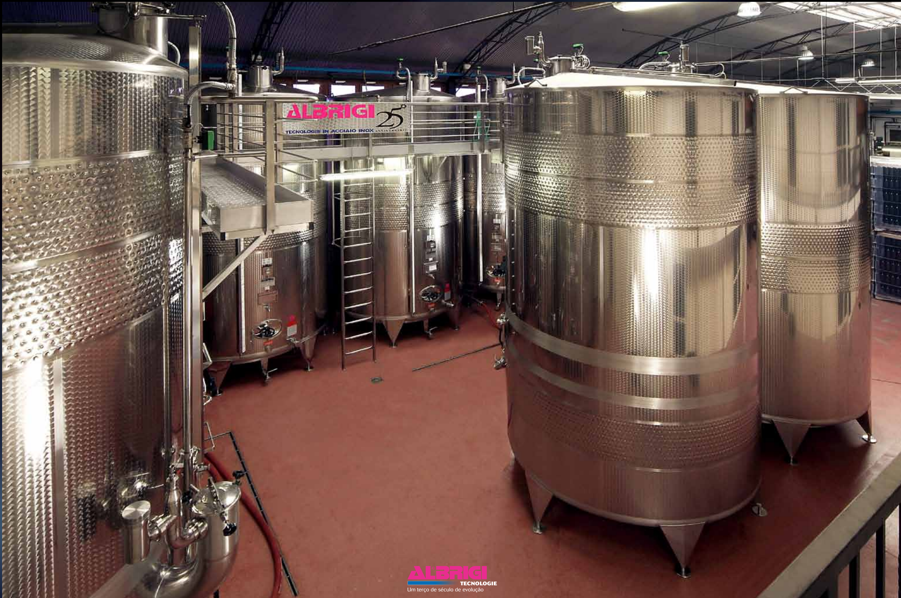
Tanques Termotank de 300 hl, Politank Termo de 150 + 150 hl e de 200 hl + 100 hl, todos com Innergas, instalação de lavagem Cleanfix e passarelas de serviço
