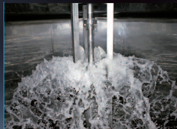
Turbotank em funcionamento na fase de lavagem
