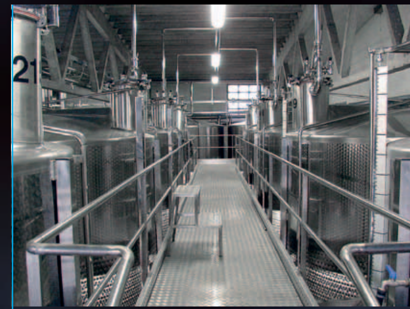
Passarela com tanques de 300 hl com grupo de segurança e instalação fixa de tubos em aço inox "Innerpipe"
