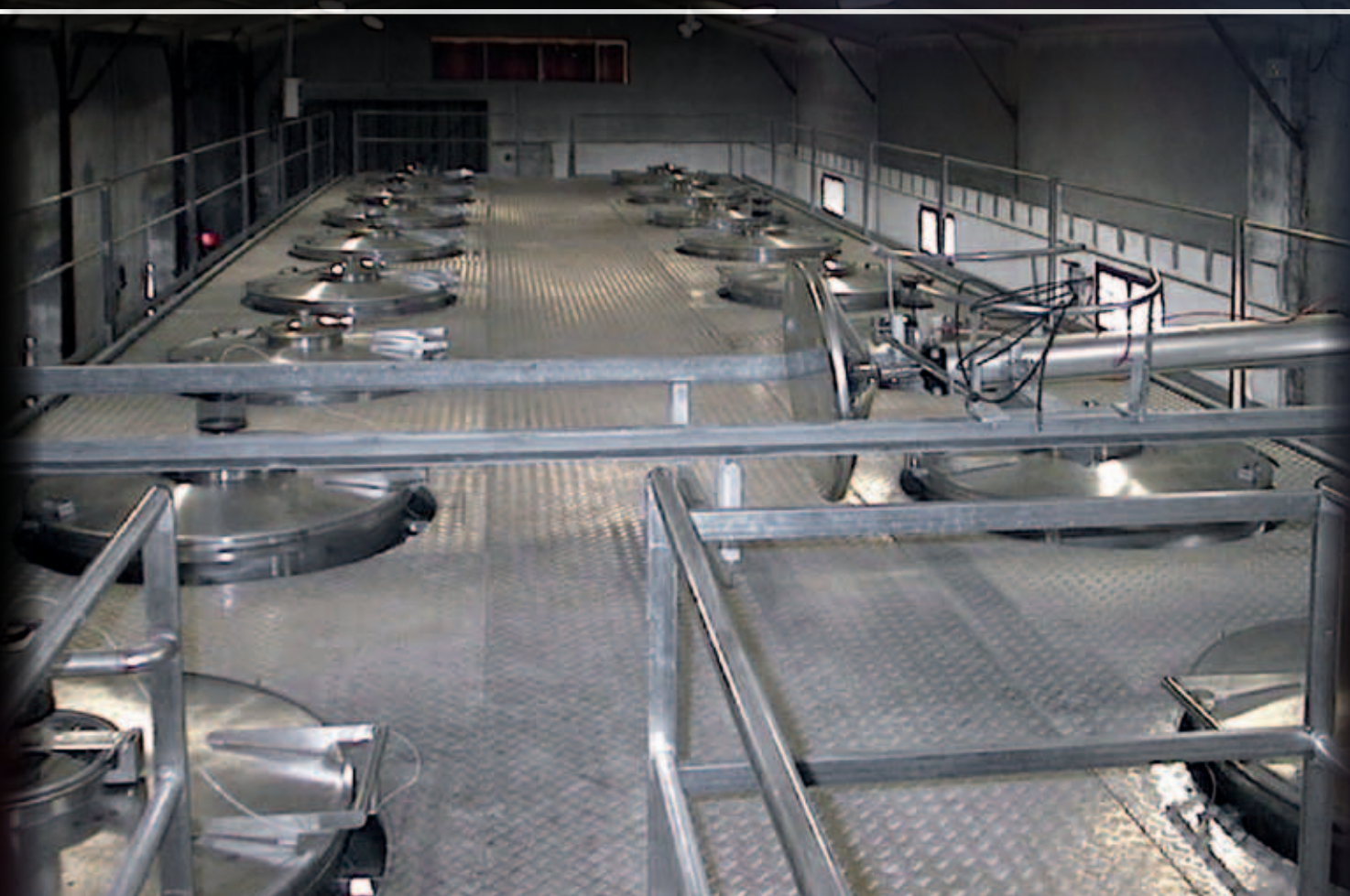
Vista de Superfollrail com 20 fermentadores de 200 hl e o monopé de recalque em posição de pausa
