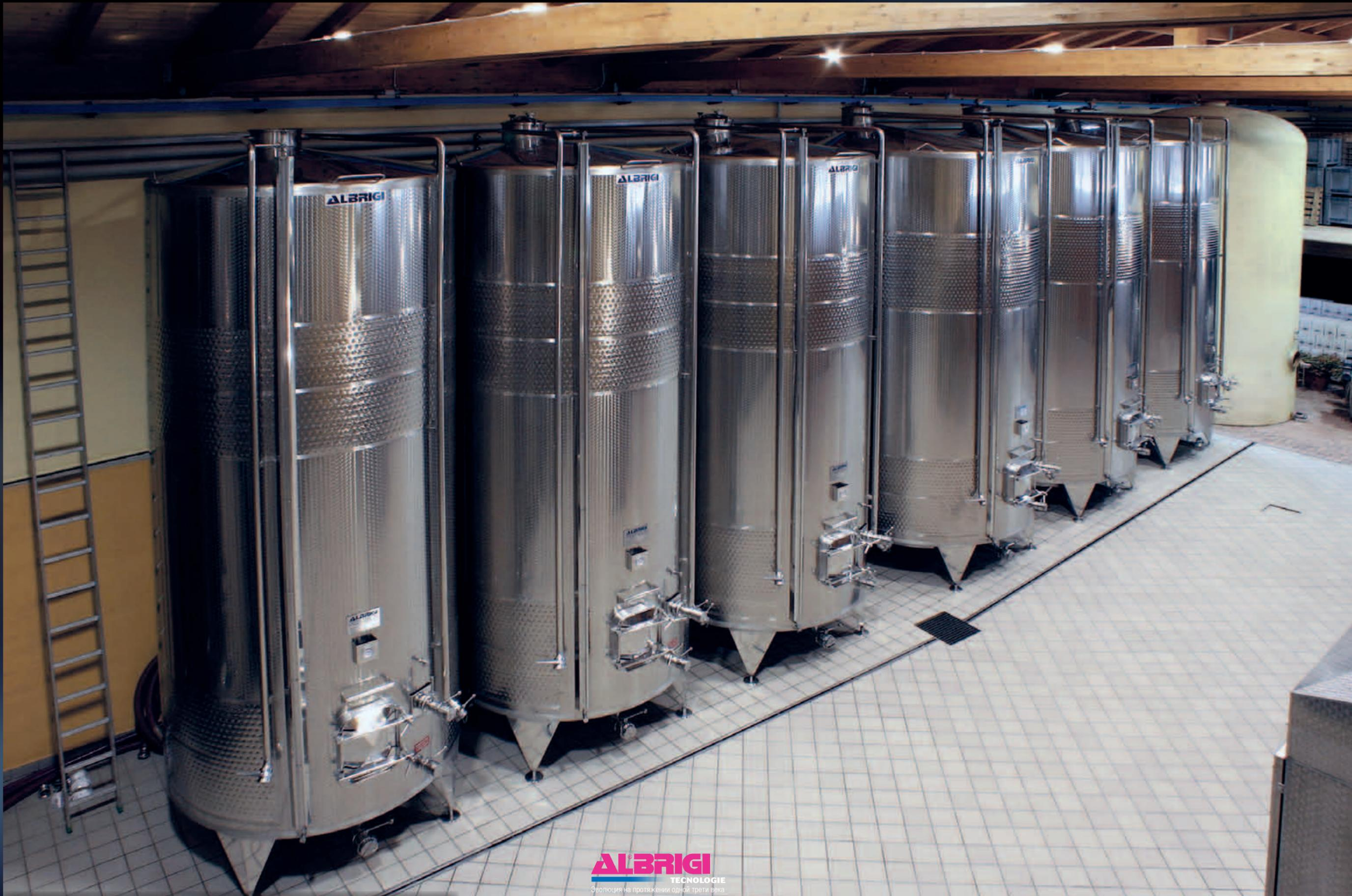
Vinotank вместимостью 150 гл с термокondиционированием Termostar Double и промывочной системой Cleanfix
