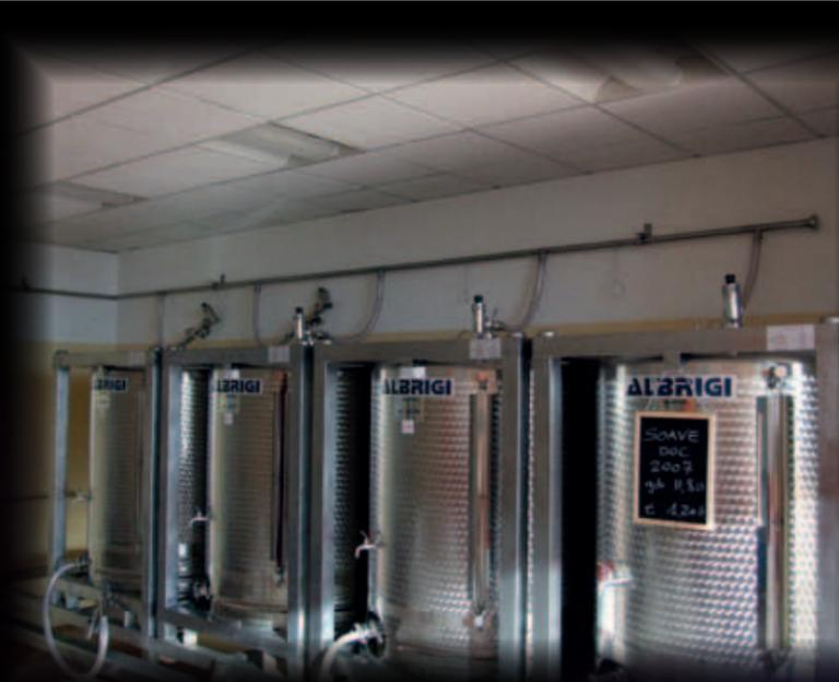
Система хранения для оптового магазина, продающего разливное вино, с системой инертизации азотом
