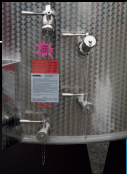
Набор клапанов Frigotank, выполняющих полную и частичную разгрузку, смачивание сушлом, а также наклонный клапан для съемного смесителя MOBILMIX
