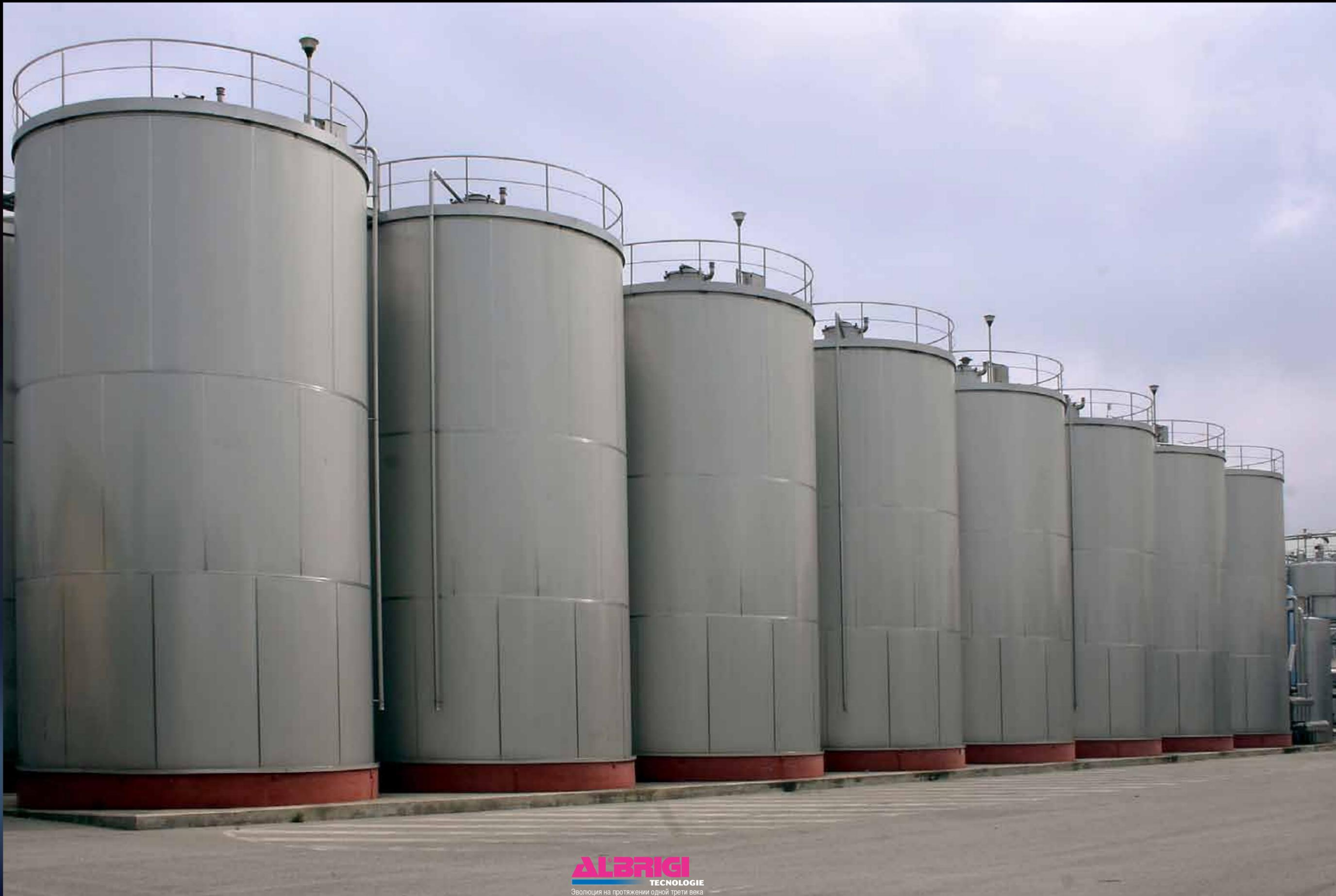
Мегатанк вместимостью 2500 гл из Aisi 304 L, верх из Aisi 316L
