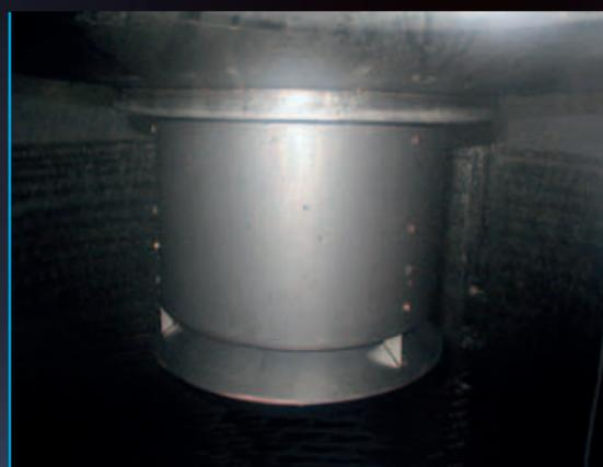
Вид снизу каскадного клапана с закрытым направляющим устройством
