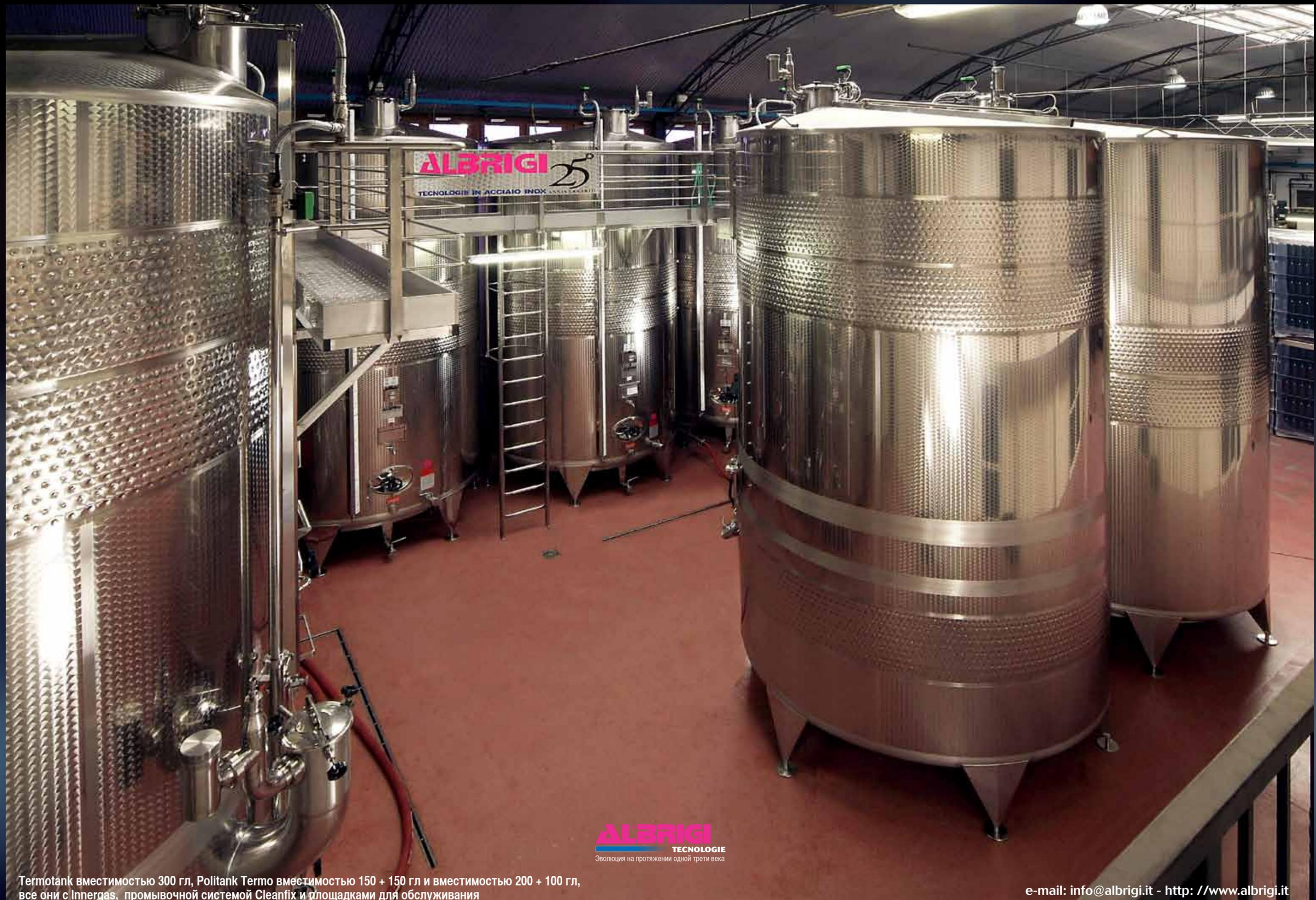
Termotank вместимостью 300 гл, Politank Termo вместимостью 150 + 150 гл и вместимостью 200 + 100 гл, все они с Innergas, промывочной системой Cleanfix и площадками для обслуживания
