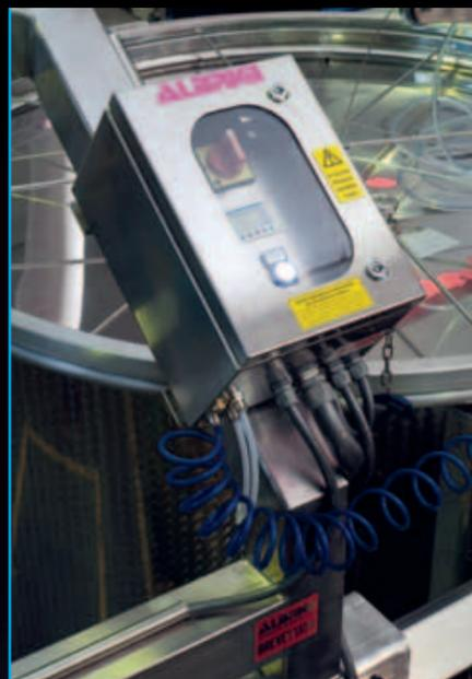
Электропневматический щит управления подъема и опускания в ручном/ автоматическом режиме
