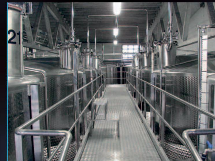
Площадка с емкостями 300 гл с предохранительным узлом и фиксированной системой труб из нержавеющей стали "Innerpipe"
