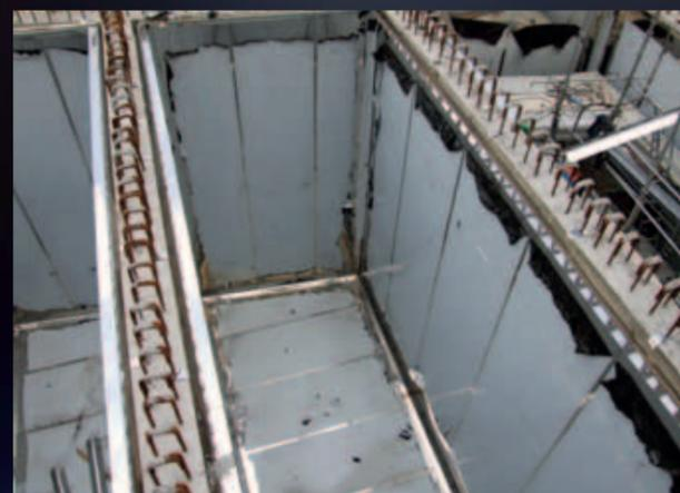
Смонтированный и армированный верх, готовый для заливки бетона
