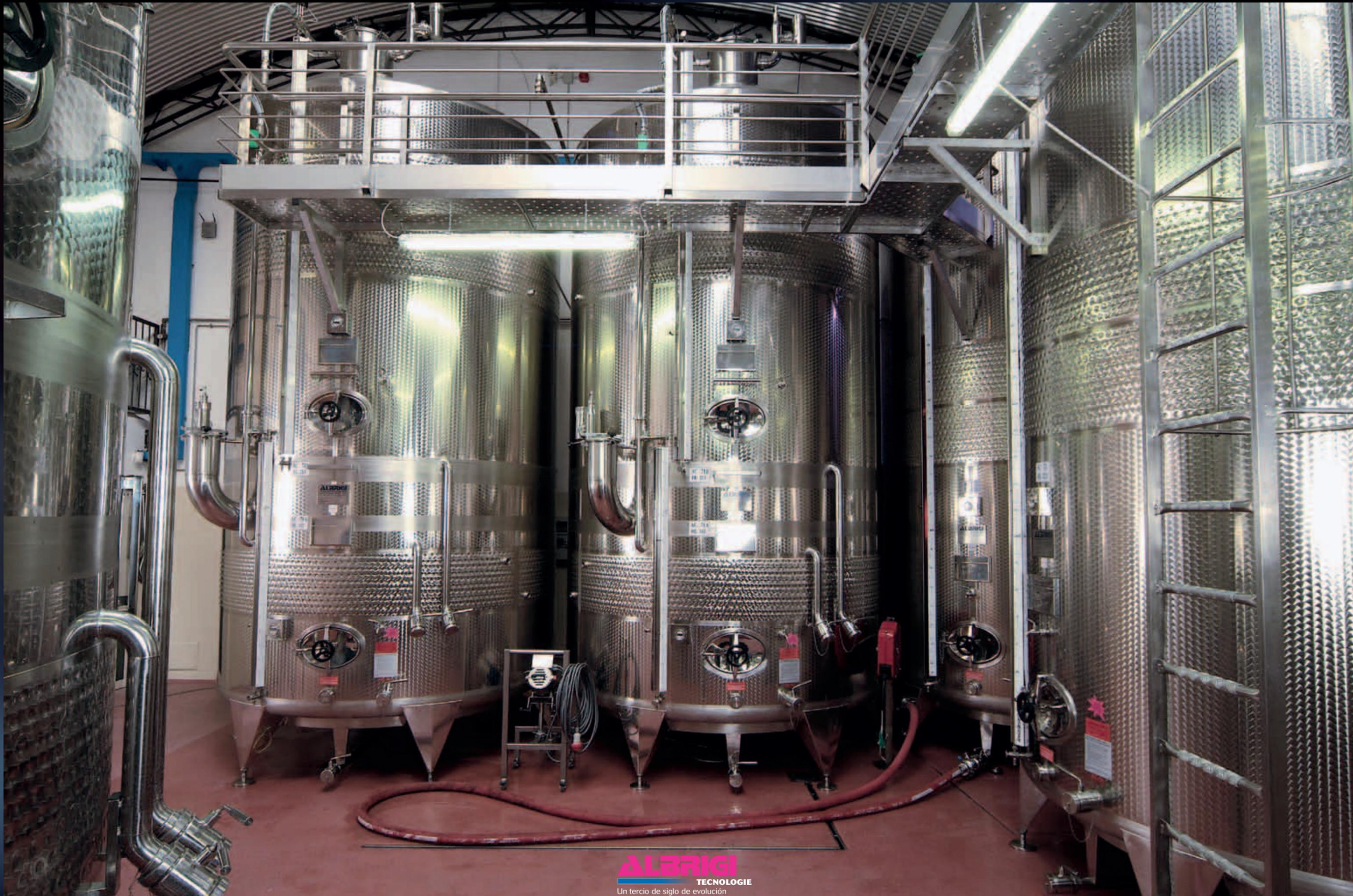
Tanques Politank de 100hl + 200 hl termocondicionados con camisa Termostar, sistema de lavado Cleanfix e Innergas
