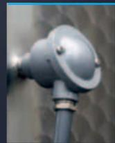
Portasonda para el control de la temperatura
