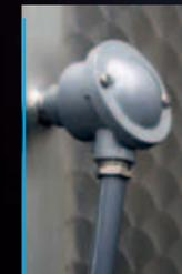
Portasonda para el control de la temperatura
