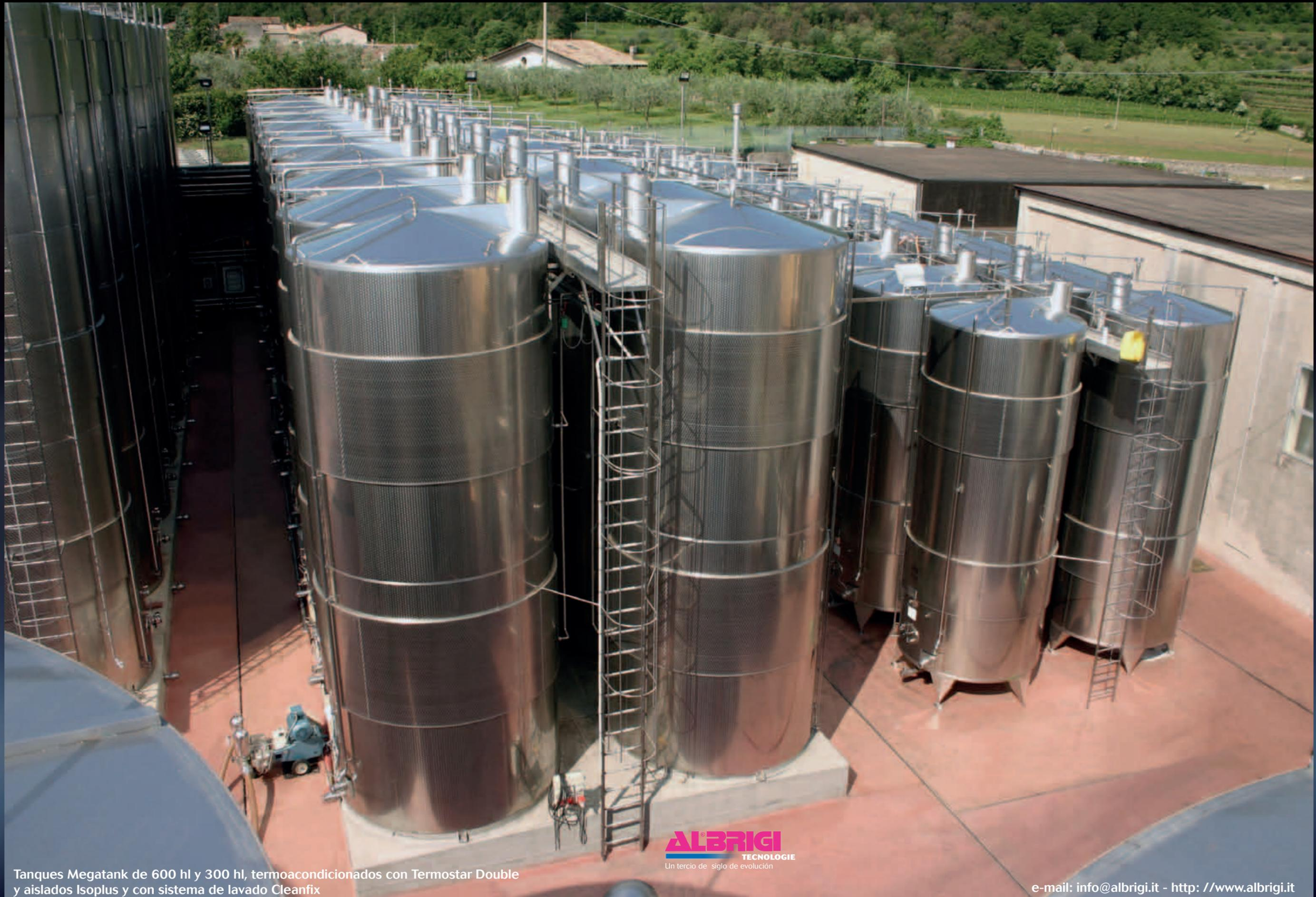
Tanques Megatank de 600 hl y 300 hl, termocondicionados con Termostar Double y aislados Isoplus y con sistema de lavado Cleanfix
