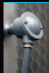
Portasonda para el control de la temperatura
