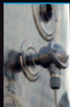
Sonda de temperatura con funda exterior
