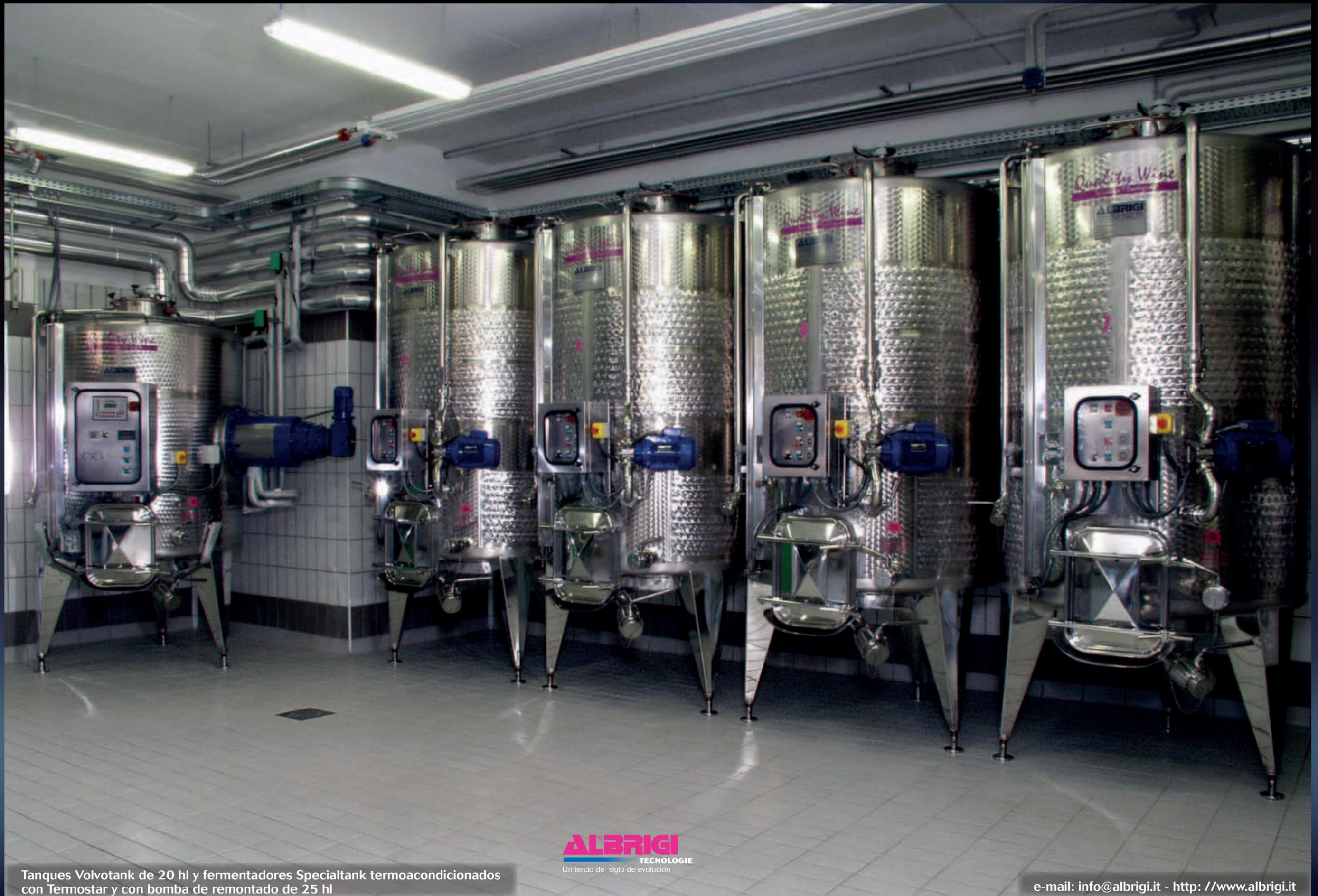
Tanques Voltotank de 20 hl y fermentadores Specialtank termocondicionados con Termostar y con bomba de remontado de 25 hl
