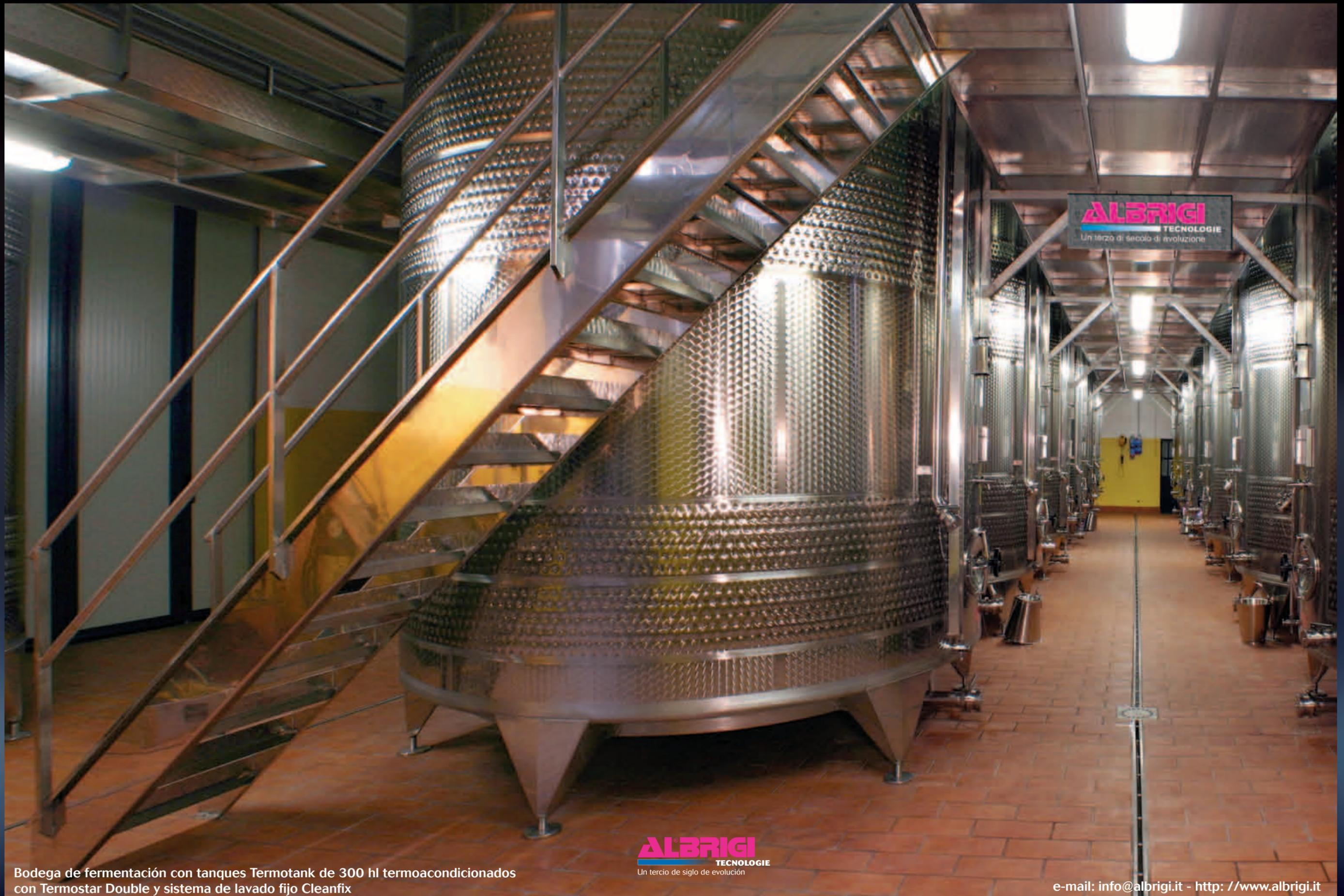
Bodega de fermentación con tanques Termotank de 300 hl termocondicionados con Termostar Double y sistema de lavado fijo Cleanfix
