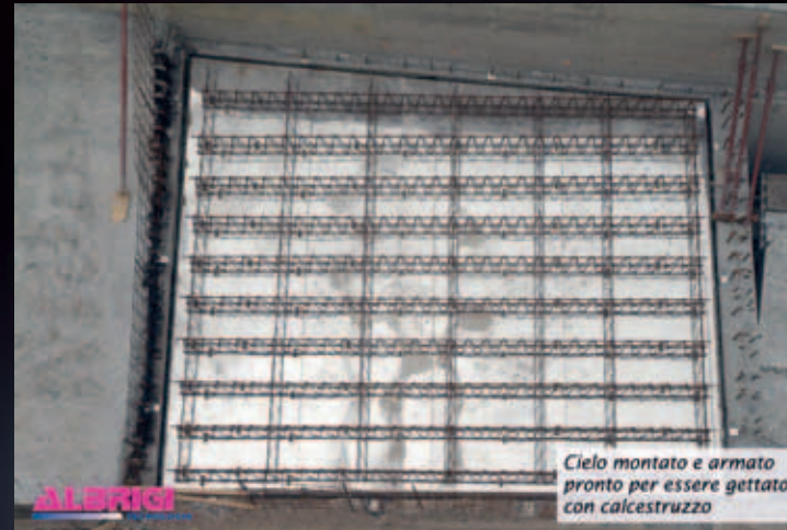
Montierte und verschalte Decke bereit zur Betonierung
