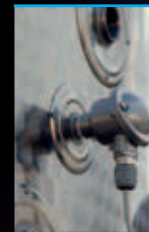
Temperaturfühler mit externer Halterung
