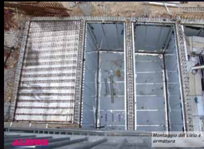
Montage von Decke und Verschalung
