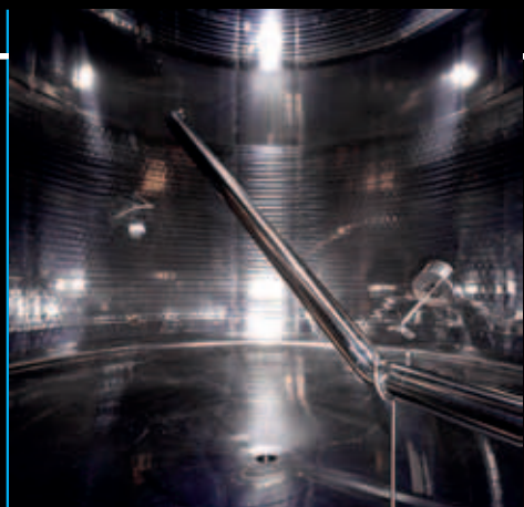
Dekantierventil, am Teilabfluss angebracht
