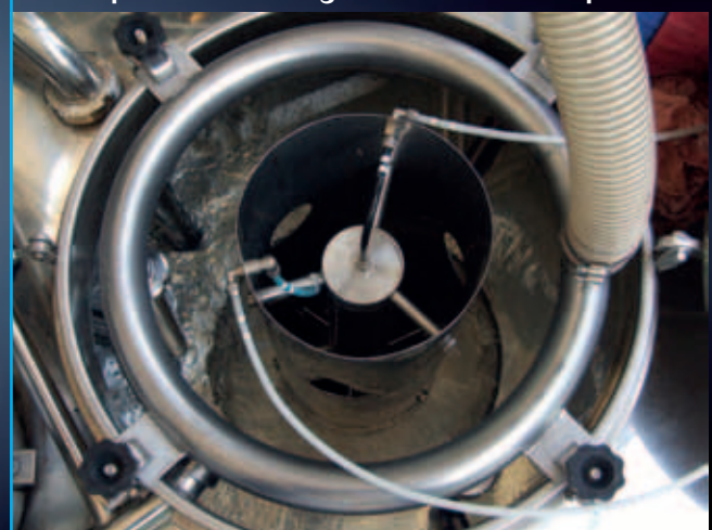
Überspülventil mit angebrachter Lufteinspritzdüse
