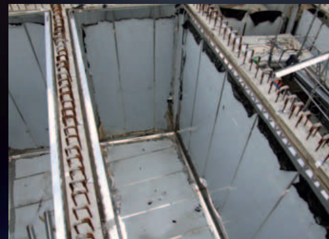
Montierte und verschalte Decke bereit zur Betonierung
