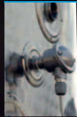
Temperaturfühler mit externer Halte- rung
