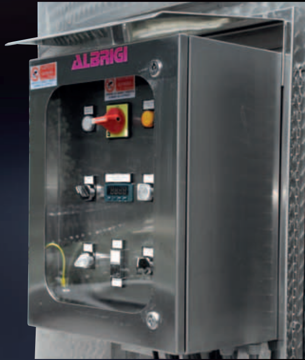
Schalttafel aus Edelstahl für Meccanotank mit allem Zubehör
