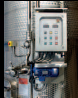
Schalttafel zur Steuerung der Remontage-Pumpe und der Unterstoßphasen
