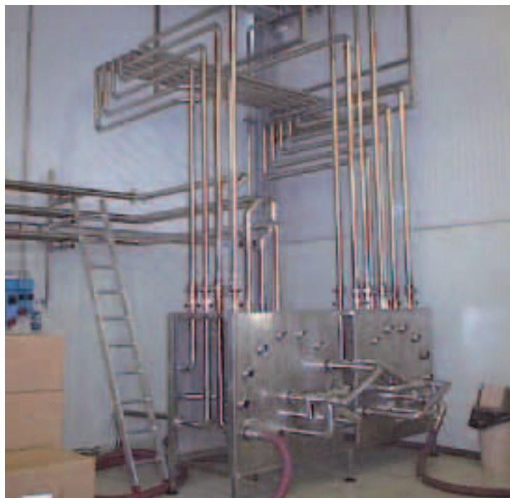
■ Vista del sistema Interchange per collegare tubi fissi ai vari serbatoi da lavare
