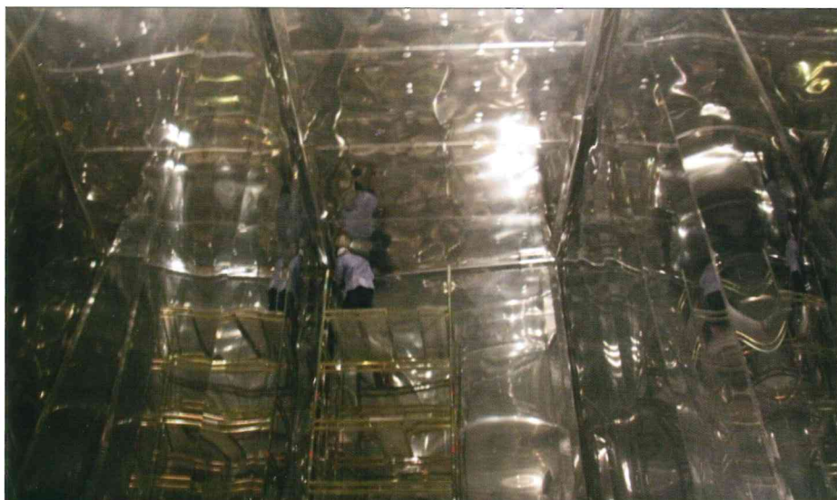
Le vasche rivestite di lamiera inox EN 1.4306 (AISI 304 L), spessori di 2 e 2,5 mm.
