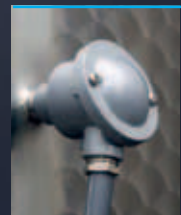
Portasonda per il controllo della temperatura
