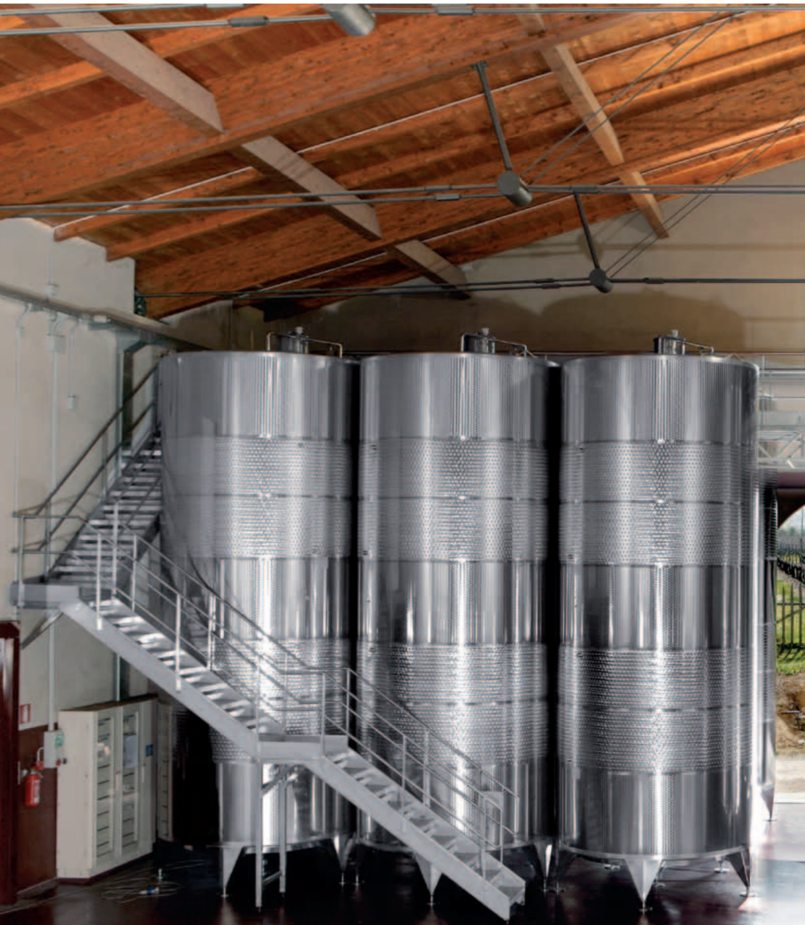
Cantina con n° 6+6 TERMOTANK da lt 30.000 con 2 intercapedini TERMOSTAR, con passerelle di servizio e scale di accesso
