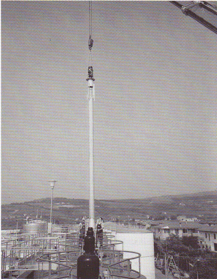
Montaggio del sistema Turbotank su serbatoi di impianti esistenti. Montage du système Turbotank sur réservoir d'installations existantes. Montierung des Turbotank Systems auf Behältern bestehender Anlagen.
